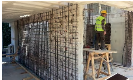
Görsel 3 Betonarme Perde ile Güçlendirme
