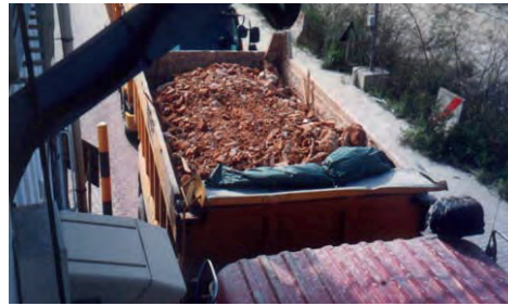
Görsel 17 Sökülmüş Betonun Nakliyesi
