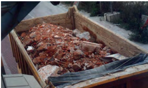
Görsel 19 Karışık (geri dönüşümü mümkün ve mümkün olmayan) yıkıntı atıklarının dolgu malzemesi olmak üzere nakliyesi
