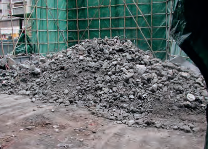
Görsel 11 Seçici Yıkımda Yapıdan Kırılarak Alınan ve Ayrı Biriktirilen Beton Parçaları
