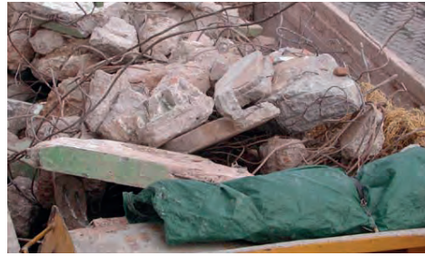
Görsel 17 Sökülmüş Betonun Nakliyesi
