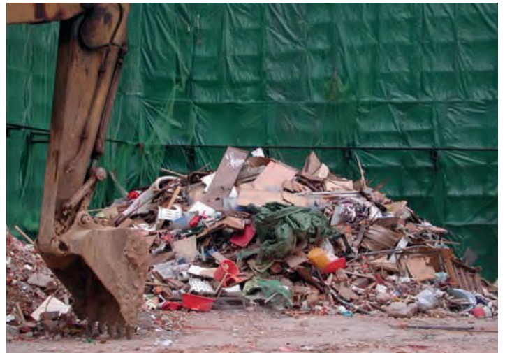
Görsel 14 Seçici Yıkımda Ayrıştırılan Inert Olmayan Malzemeler
