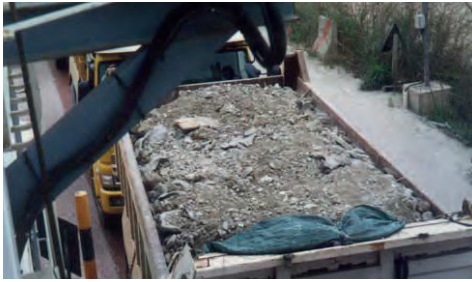
Görsel 16 Ayrıştırılmış Kırık Betonun Nakliyesi
