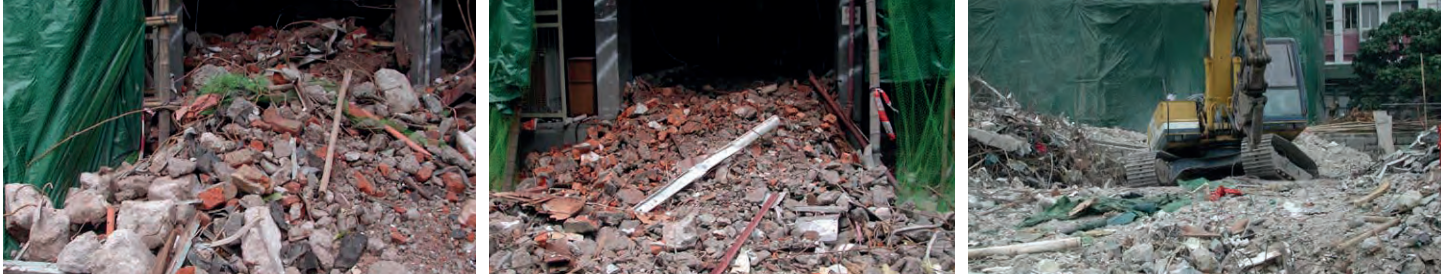
Görsel 15 Seçici Yıkım Uygulanmaması Durumunda Karışık Yıkıntı Atıkları
