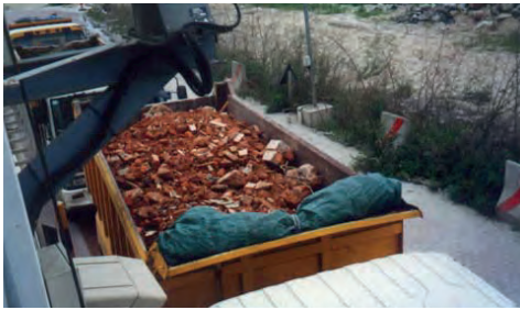
Görsel 16 Ayrıştırılmış Kırık Betonun Nakliyesi
