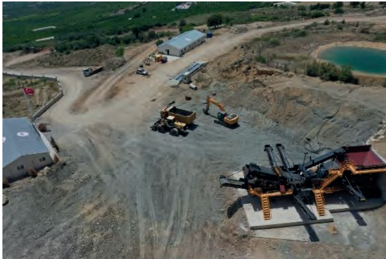
Görsel 32 Mersin Büyükşehir Belediyesi Yıkıntı Atığı Geri Dönüşüm Tesisi Kuşbakışı
