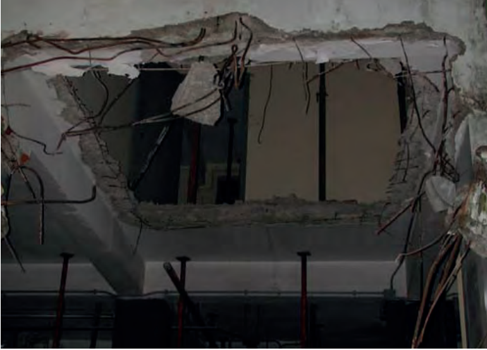
Görsel 9 Seçici Yıkım Uygulanmış Bir Yapı
