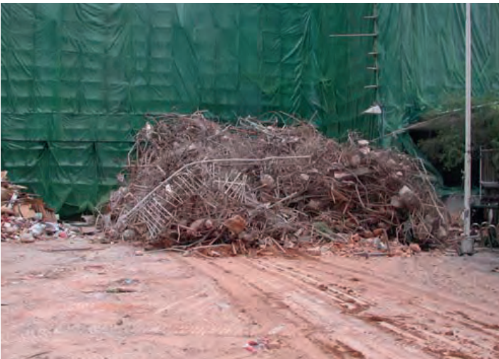
Görsel 13 Seçici Yıkımda Yapıdan Sökülerek Alınan ve Ayrı Biriktirilen Çelik
