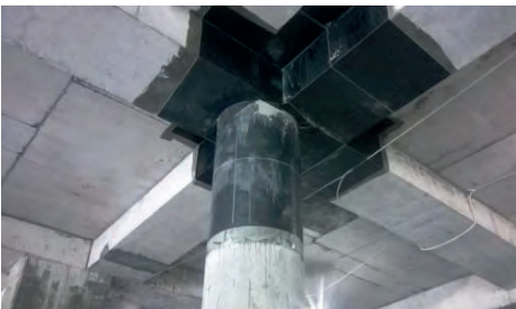
Görsel 5 Karbon Elyaf Lifli Kompozitler ile Güçlendirme
