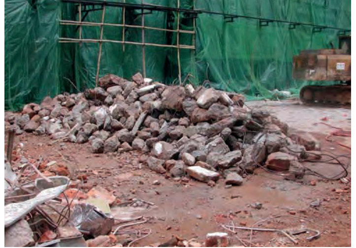
Görsel 10 Seçici Yıkımda Yapıdan Sökülerek Alınan ve Ayrı Biriktirilen Beton Parçaları
