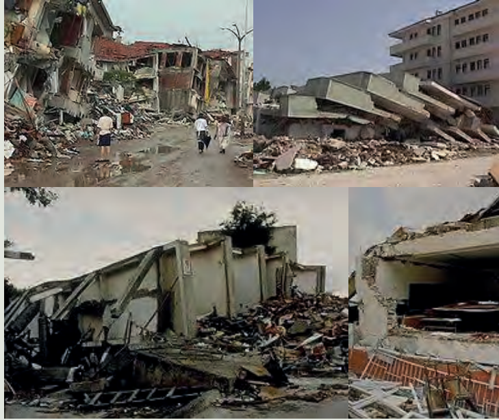
Görsel 24 Gölcük Depreminde Yıkılan Binalar
